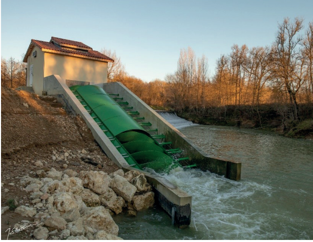
Production d'hydroélectricité à Graziac
