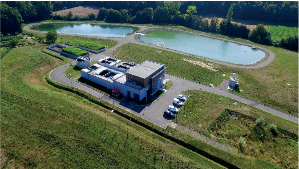
Usine de production d'eau potable de Montégut / Arros (photo TRIGONE).
