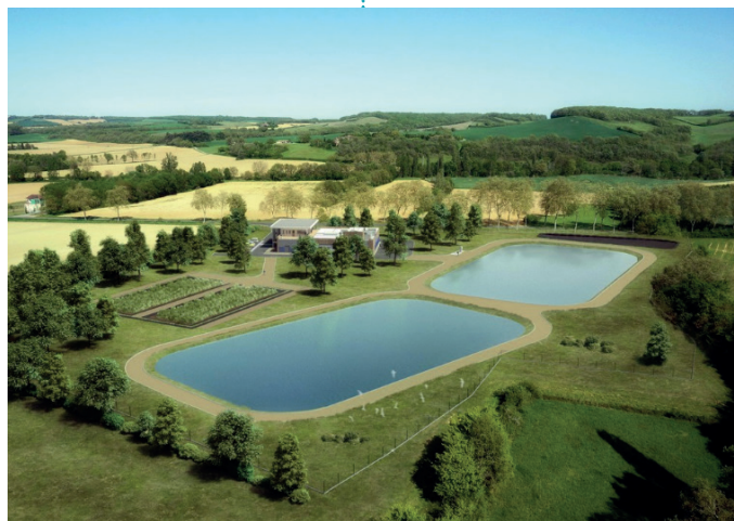
Usine de production d'eau potable de Saint-Jean-Poutge (photo TRIGONE)
